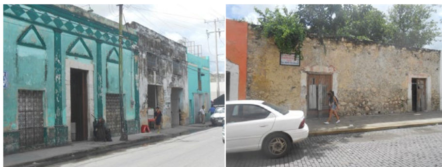
Fotografía 6. Deterioro de inmuebles, Calle 71. Fuente: Susana Pérez Medina, septiembre del 2015.
