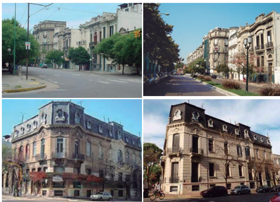
Fotografías 13, 14, 15 y 16. Las dos fotos de arriba, Boulevard Caseros antes y después de la intervención urbana. Las fotos de abajo, son el antes y el después de un edificio privado, que fue intervenido después de la obra pública sobre el boulevard. Fuente: DGCH.
