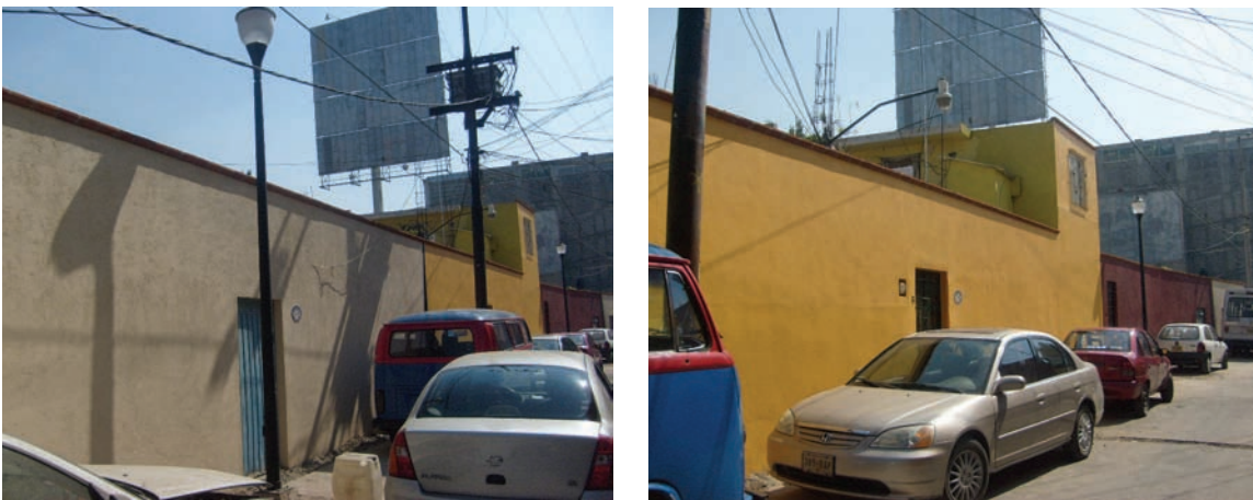
Se muestran los diversos predios antes de las labores de mejoramiento de fachadas. Enseguida, se puede apreciar la misma serie de predios una vez hechas las mejoras.
