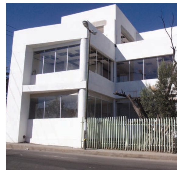
La Casa de la Cultura con sus modernas instalaciones y acabados exteriores.
