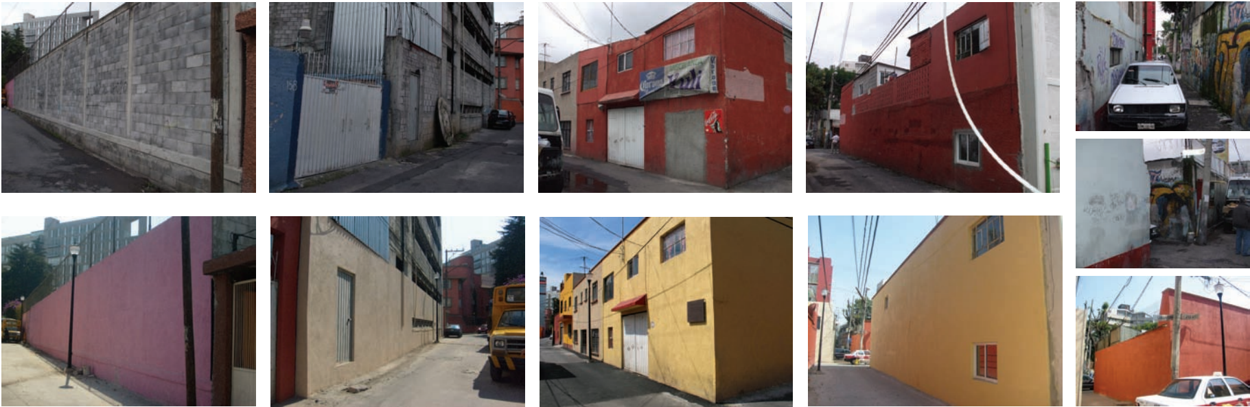
Detalle del antes (fila de arriba) y después (fila de abajo) de algunas fachadas beneficiadas con el PCMB 2008.
