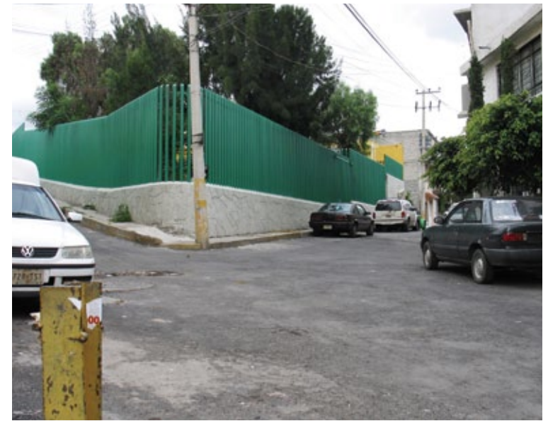
El área rehabilitada con barda tubular integrada, con lo cual se tuvo mayor protección y seguridad.
