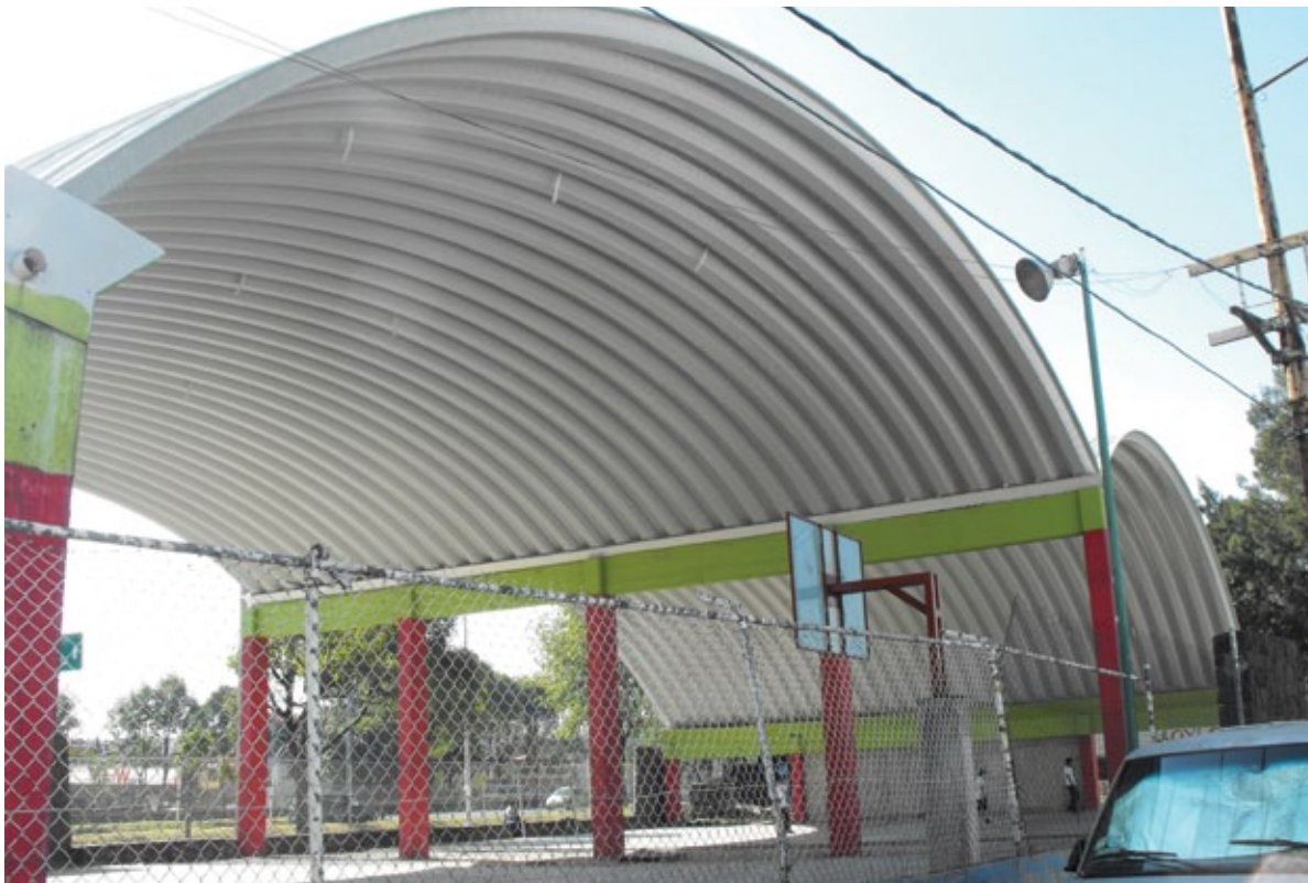
En la imagen podemos observar las instalaciones de la cancha de basquetbol en primer plano, con cubierta en forma de arco, que es empleada por jóvenes y niños para actividades recreativas y deportivas.
