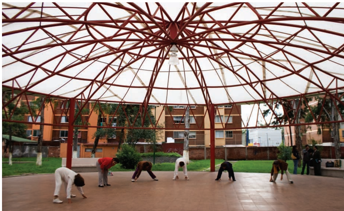
La colocación de la cubierta permitió que las personas de la tercera edad aprovecharan ese espacio y desarrollaran actividades deportivas.
