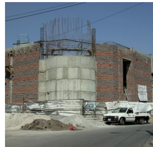
El Teatro del Pueblo durante la construcción de sus instalaciones.
