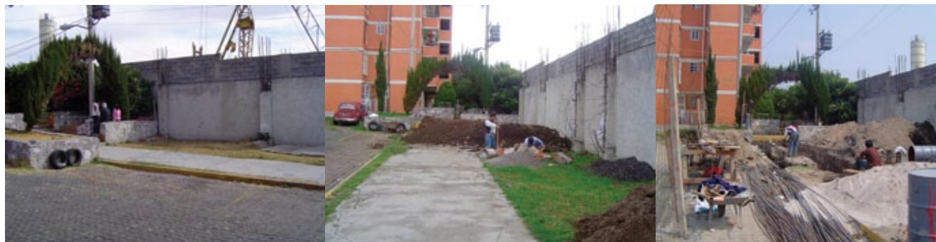
El predio y el proceso de construcción del Salón de Usos Múltiples Bilbao.
