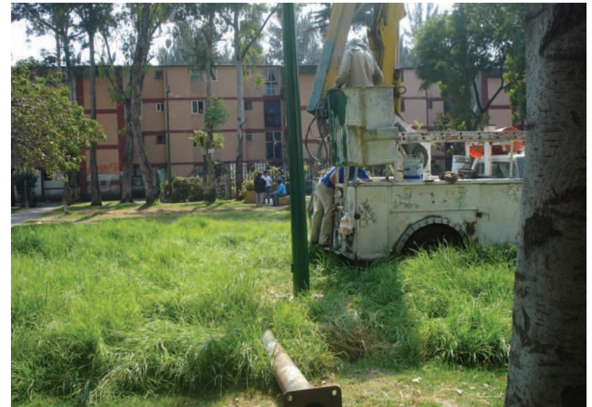
En la imagen de esta página se puede observar el estado en que se encontraban las áreas verdes de la colonia; enseguida, en la siguiente página, se aprecia la renovación de éstas, así como la instalación de juegos infantiles y luminarias.
