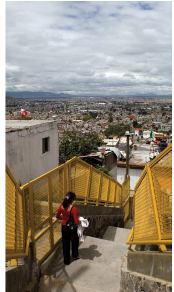
Las escaleras con pasamanos brindan mayor seguridad a los transeúntes.
