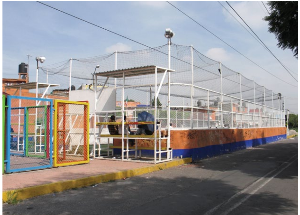
La cancha deportiva, ubicada sobre el camellón, con luminarias y protección para mayor seguridad.
