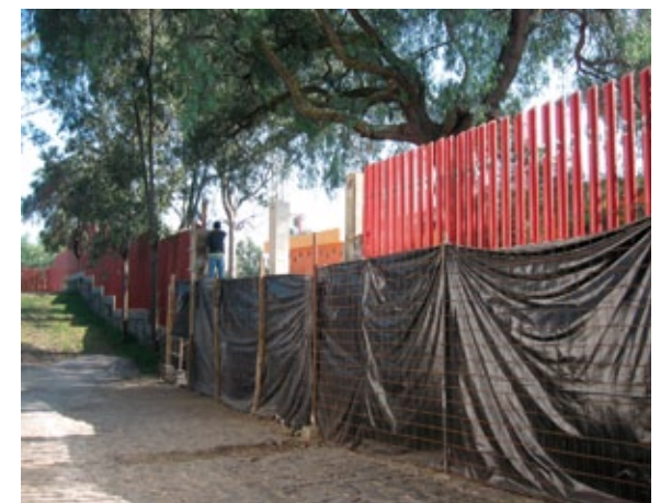
En la fotografía superior se muestra el derribamiento de la antigua barda y en la inferior, el proceso de instalación de la barda tubular.
