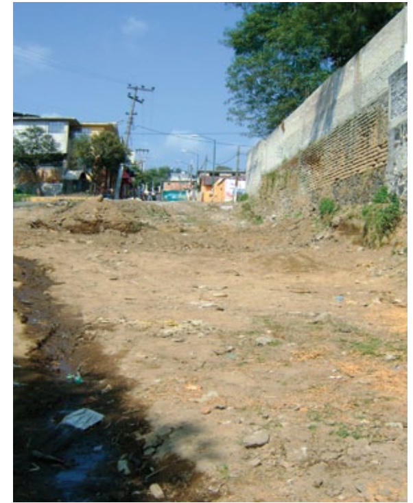
El predio que fue utilizado para construir el Centro de Convivencia Comunitaria Ajusco.
