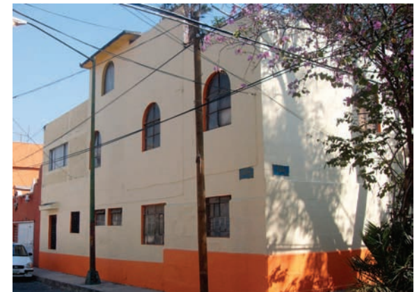
Fachada de un predio antes (arriba) y después (abajo) de la rehabilitación de la fachada.
