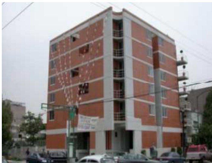
Figura 2 Edificio de mampostería confinada, Proyecto Xola (Lugo, 1999)
