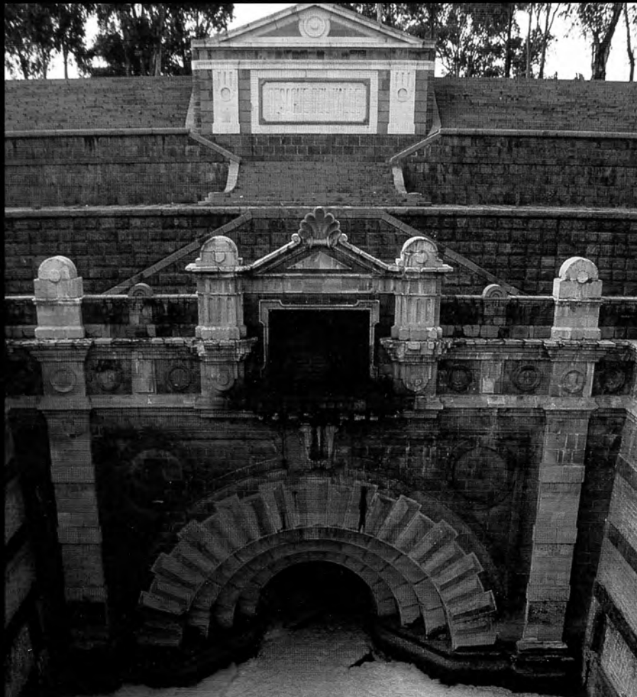
Portal de entrada al túnel viejo de Tequixquiac, 2001.
