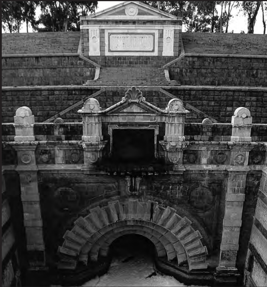
Portal de entrada al viejo túnel de Tequixquiac Jorge Pablo de Aguinaco, en El futuro del agua en México , BANOBRAS, 2001
