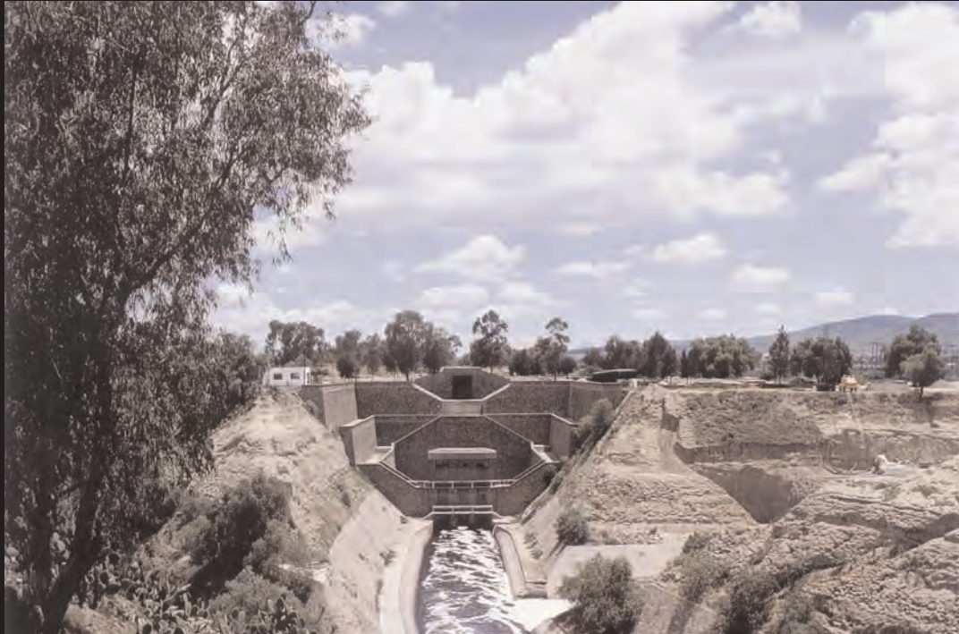
Salida del nuevo tunel de Tequixquiac Eduardo del Conde, en El futuro del agua en México , BANOBRAS, 2001
